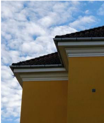
Foto - Profileret gesims på bygningen fra 1926
