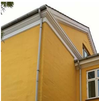
Foto - Profileret gesims og savsnitsgesims på bygning fra 1871
