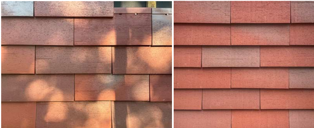
Figur 1. Princip for skærmtegl.
