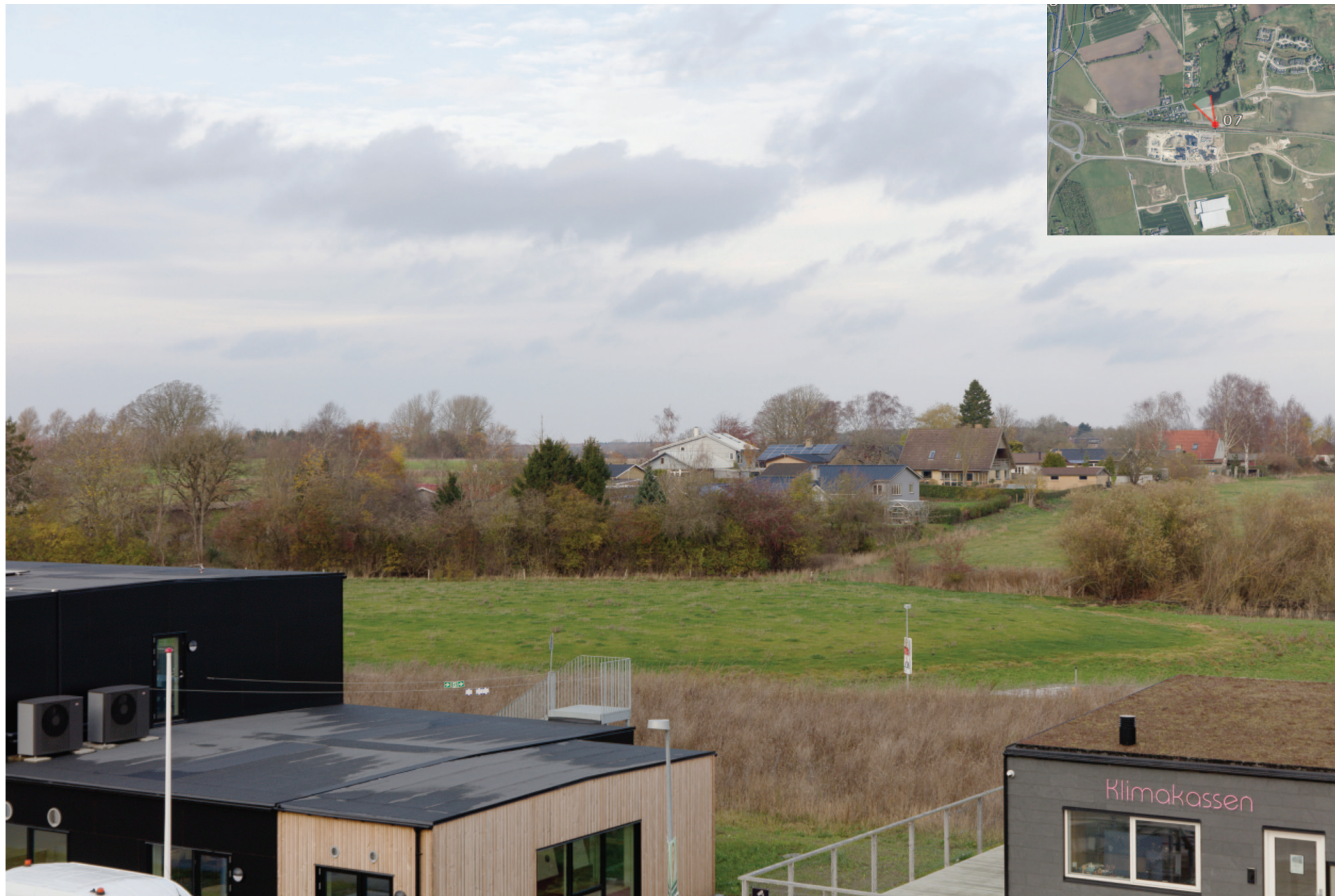
Eksisterende forhold, set fra Vinge stationsbro.
