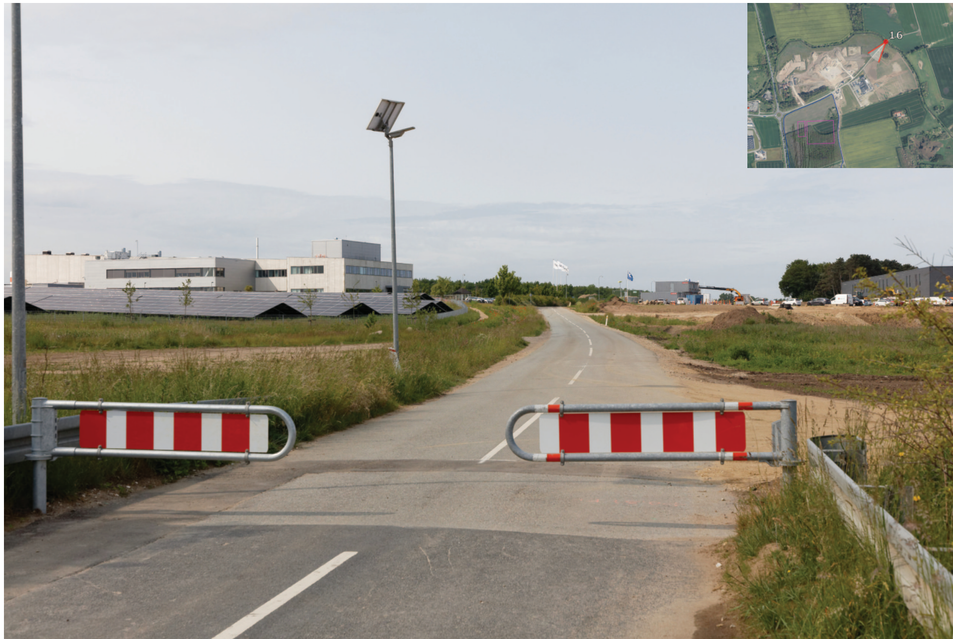
Eksisterende forhold, set fra Haldor Topsøe Park mod vest.
