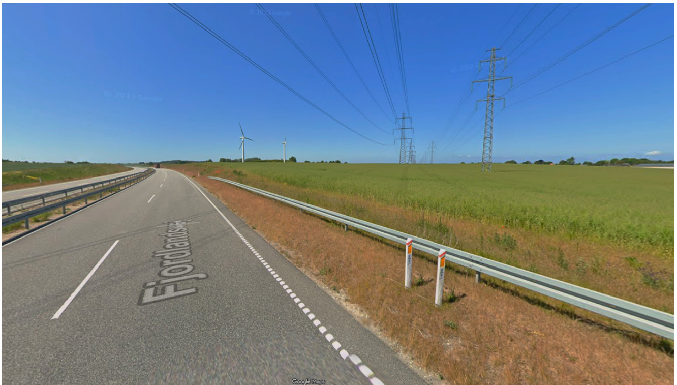
Foto af de eksisterende forhold uden batteripark set nordøst fra Fjordlandsvej
