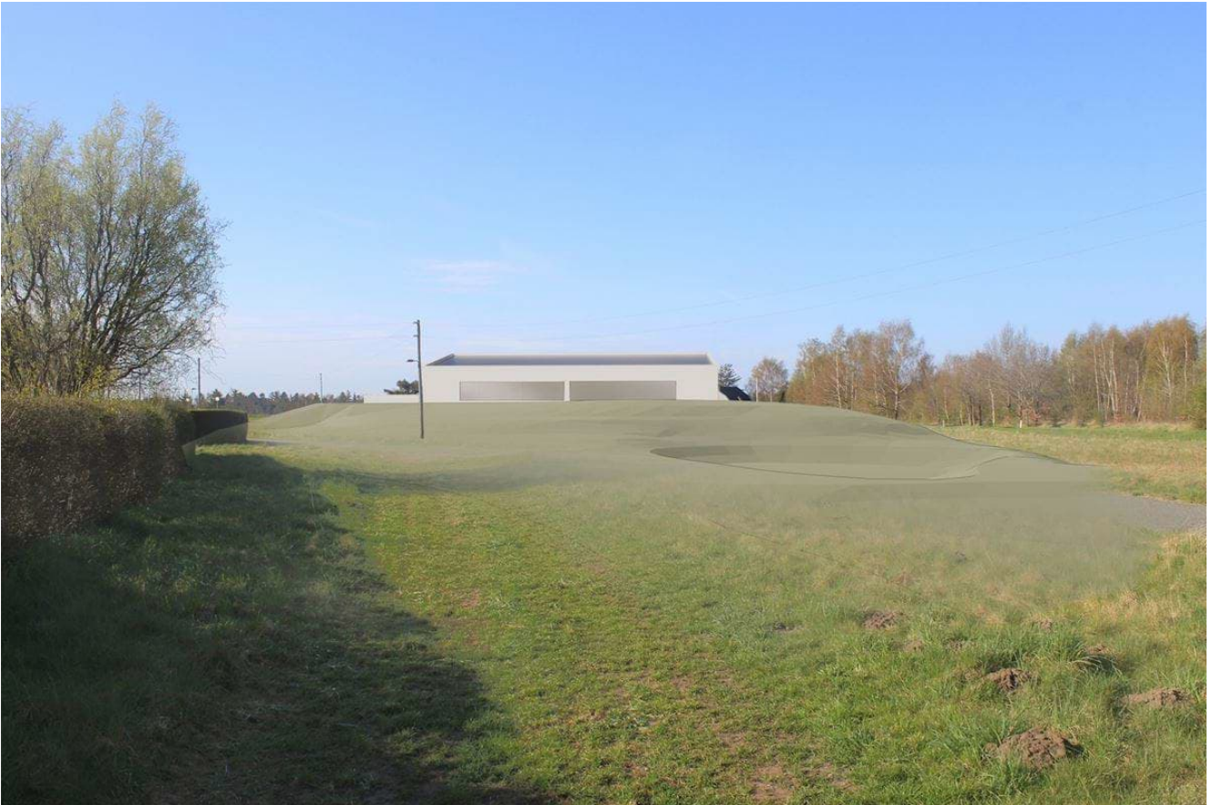
Visualisering 4: Eksempel på mulig bebyggelse uden udvidelse set fra nordøst ved Femhøj Stationsvej.
