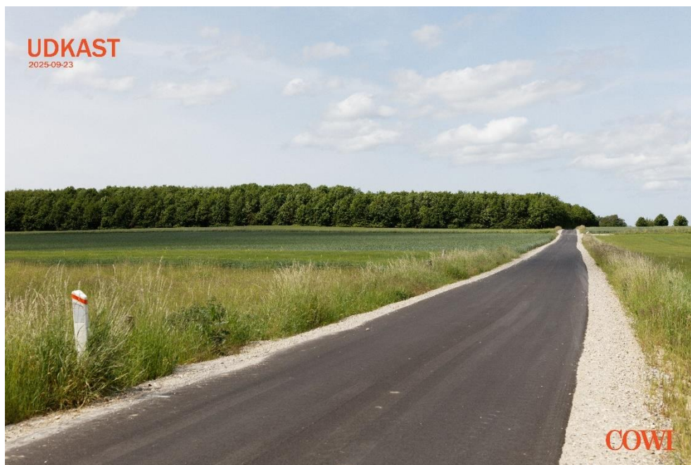
Figur 14-9 Eksisterende forhold ved udsigten til værkstedet fra Gammel Slangerupvej. COWI 2025.
